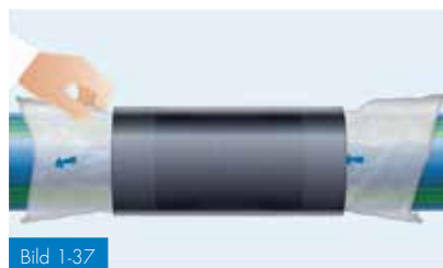
Bild 1-37 Centrering av krympmuffen och borttagning av skyddsfolien
