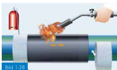
Bild 1-38 Påkrympning med en mjuk gaslåga
