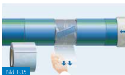
Bild 1-35 Isolering av elektrisk anslutning
