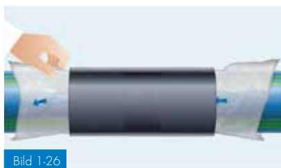
Bild 1-26 Centring av krympmuffen och borttagning av skyddsfolien
