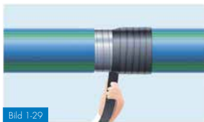
Bild 1-29 Lindning av skarven med Densolen-tejp AS 40
