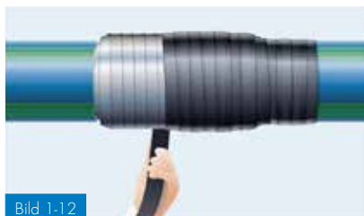
Bild 1-12 Lindning av elektrosvetsmuffen med Densolen-tejp AS 40
