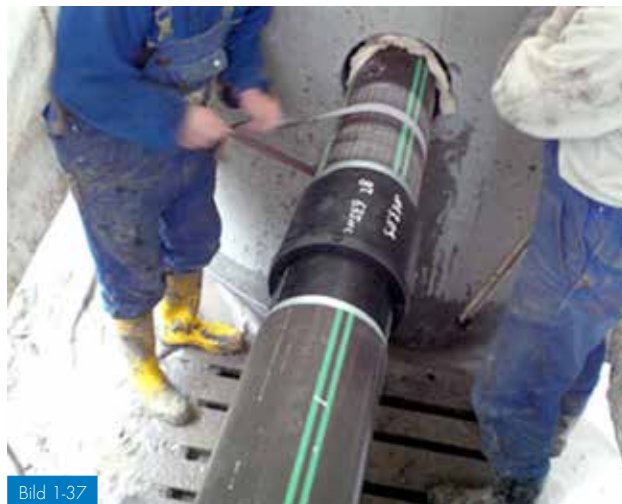
Bild 1-37 Slipning och rengöring av manteln
