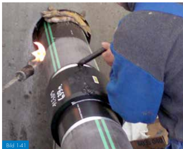
Bild 1-41 Isolering av elektriska kontakter
