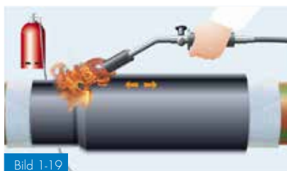
Bild 1-19 Påkrympning med mjuk gaslåga
