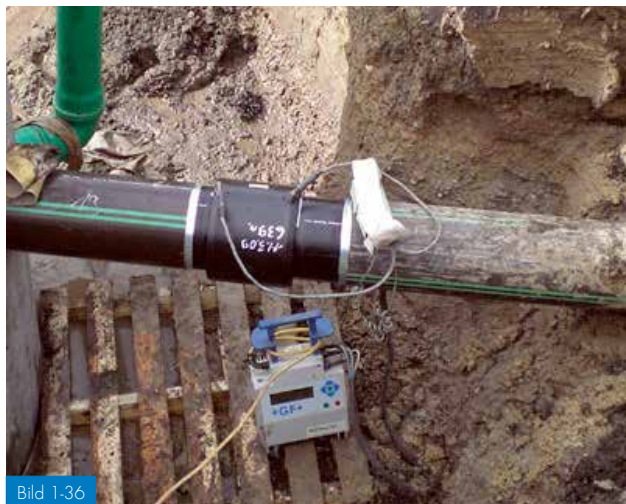
Bild 1-36 Svetsning av elektrosvetsmuff
