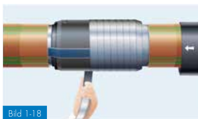
Bild 1-18 Lindning av elektrosvetsmuff med aluminiumtejp
