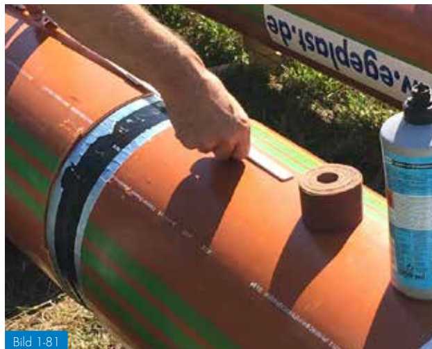
Bild 1-81 Markering av krypmområdet på båda sidor av skarven
