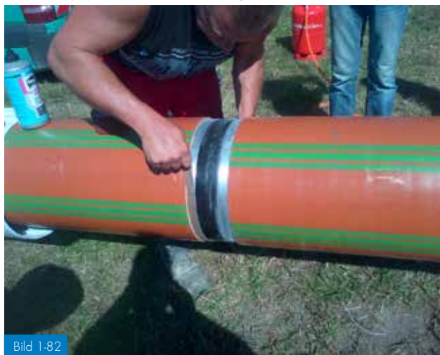
Bild 1-82 Slipning av aluminiumskiktet för att avlägsna grundfärg
