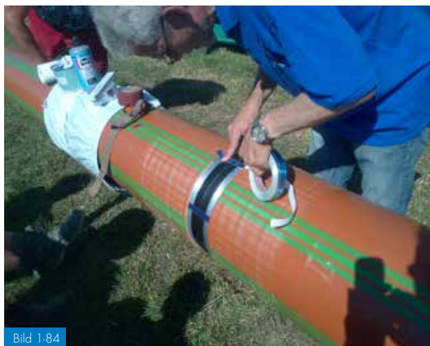
Bild 1-84 Upprättande av elektrisk anslutning
