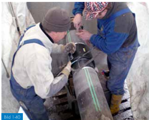
Bild 1-40 Borttagning av kontaktstiften
