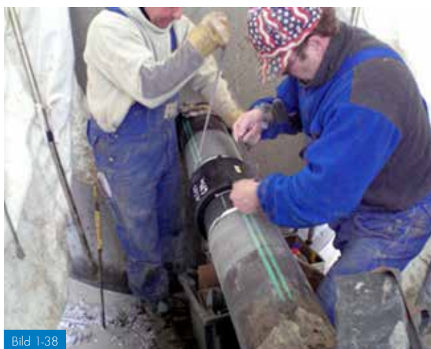
Bild 1-38 Slipning av aluminiumskiktet för att avlägsna grundfärg
