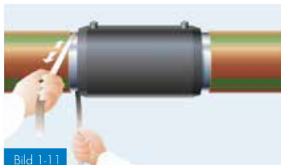
Bild 1-11 Slipning av aluminiumskiktet
