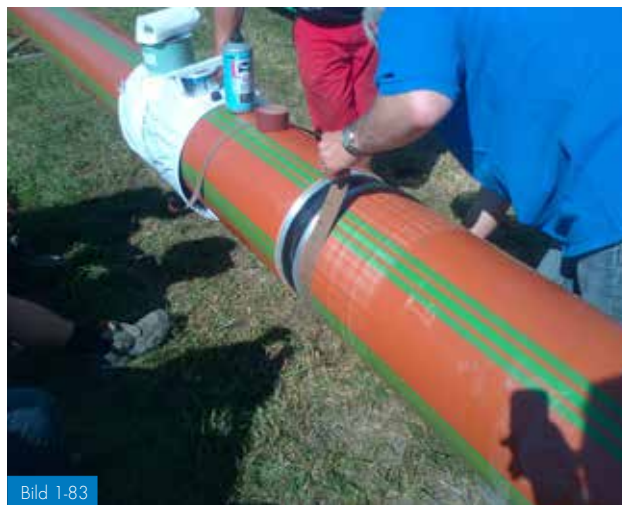
Bild 1-83 Slipning och rengöring av manteln
